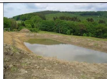
*Le bassin de récupération et de stockage des eaux pluviales avant écoulement dans le ru des prés Terziaux*
